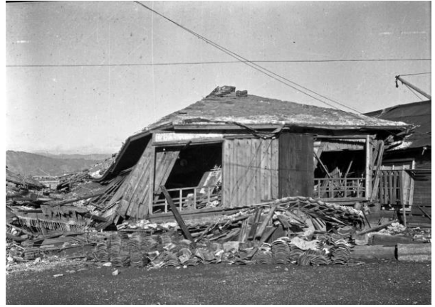
昭和 21 年 12 月 29 日 2 階建築の倒壊状況 (階下のみ潰滅) 高知市棧橋通埋立地
