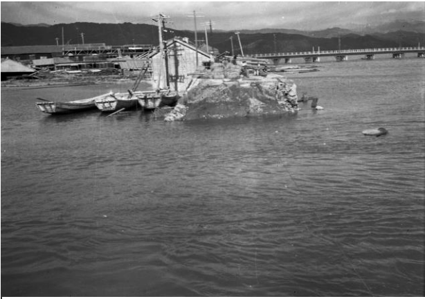
昭和 21 年 12 月 24 日 地盤沈下と堤防の陥没欠損、 下知方面の浸水、国分川西岸、葛島橋より 100m 南
